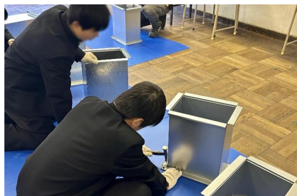
▲空調用のダクト組立ての様子（株式会社竹本設備 様）
