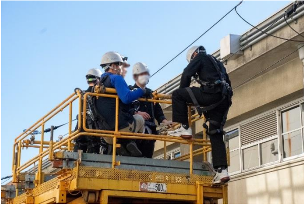
▲高所作業車に乗り込み作業現場の高さを体験（株式会社原口電設様）
